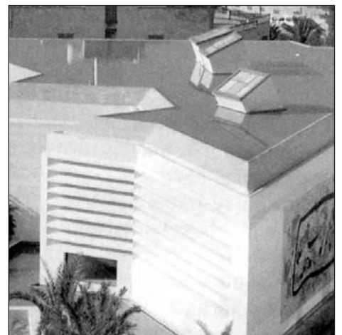
La cubierta de la Fundación Miró incorpora lámina sintética de PVC-P
